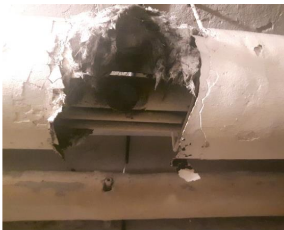
Rys. 2. Instalacja c.o. w obrębie pomieszczenia węzła: brak izolacji termicznej instalacji prowadzonej poza pomieszczenie węzła oraz uszkodzenia izolacji termicznej przewodów
