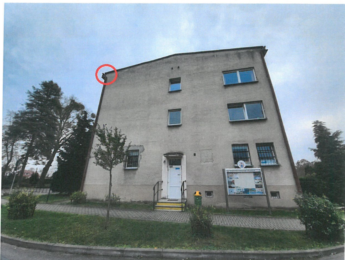
Fot. 1 Ściana szczytowa północna z potencjalną niszą wróbla/jerzyka i nietoperzy.
