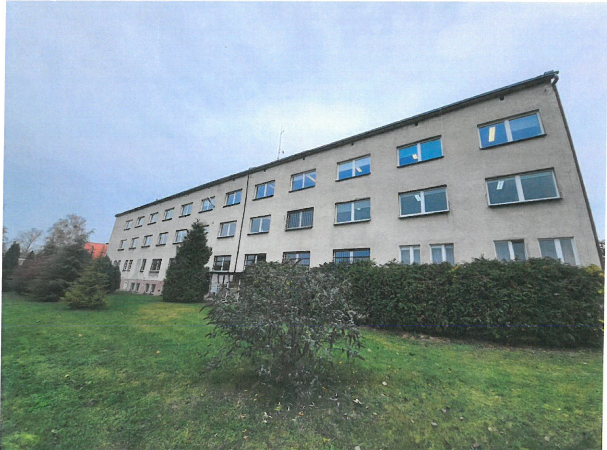
Fot. 7 Ściana podłużna zachodnia – brak potencjalnych nisz chronionych gatunków.
