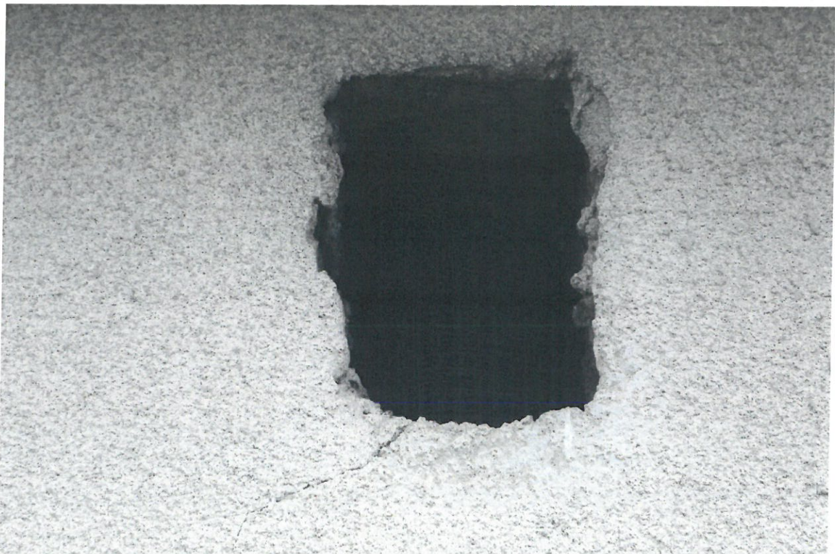
Fot. 10 Wszystkie otwarte otwory wentylacyjne strychu są zabezpieczone od wewnątrz siatką.
