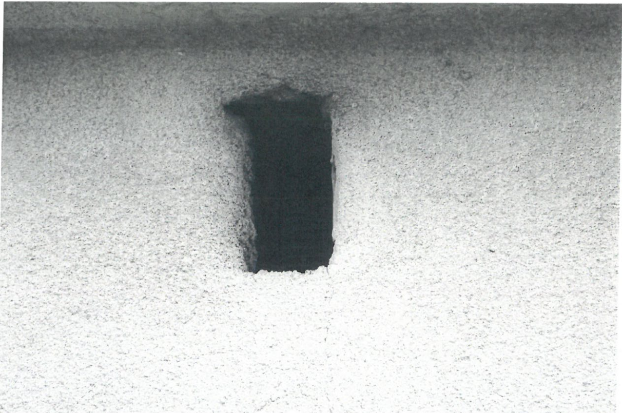
Fot. 9 Wszystkie otwarte otwory wentylacyjne strychu są zabezpieczone od wewnątrz siatką.
